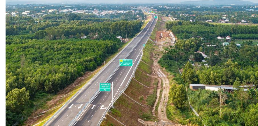
HHV tiếp tục được chọn quản lý, vận hành các tuyến cao tốc Bắc – Nam
