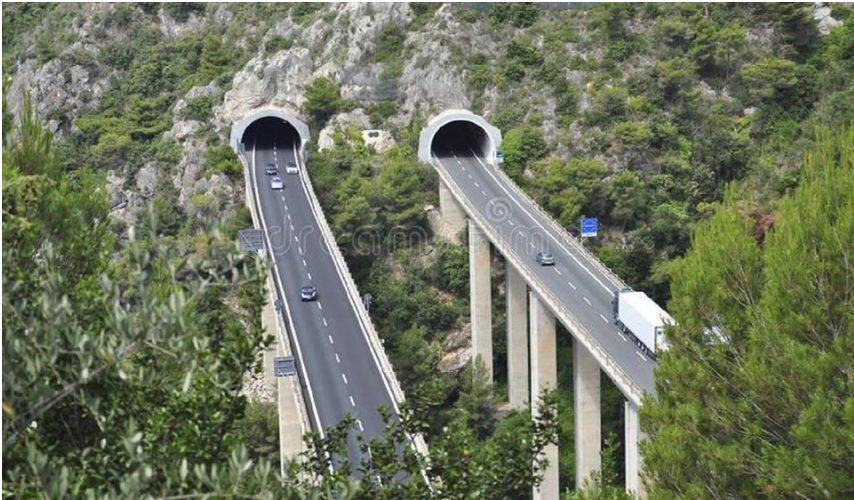
Son La – Dien Bien Expressway
