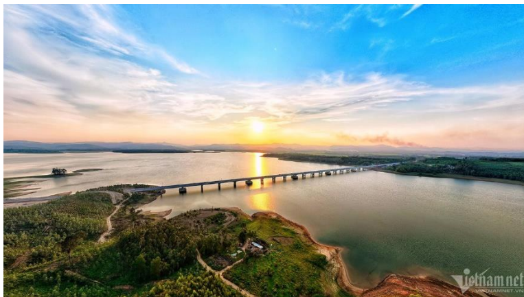
Dự án đường cao tốc Mai Sơn - QL45
