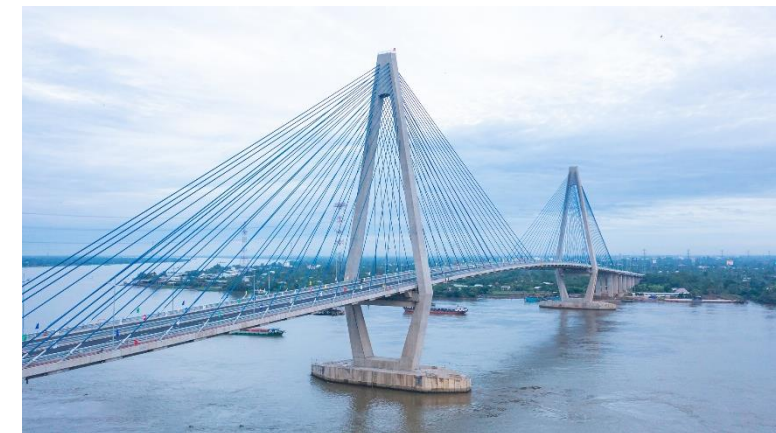
Dự án cầu Mỹ Thuận 2
